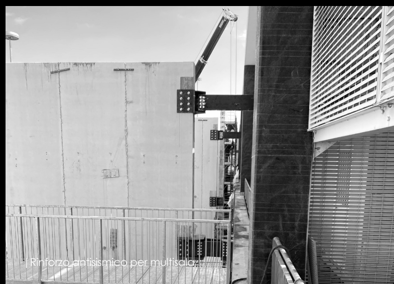
| Rinforzo strutturale per ampliamento passaggio parcheggio sotterraneo
