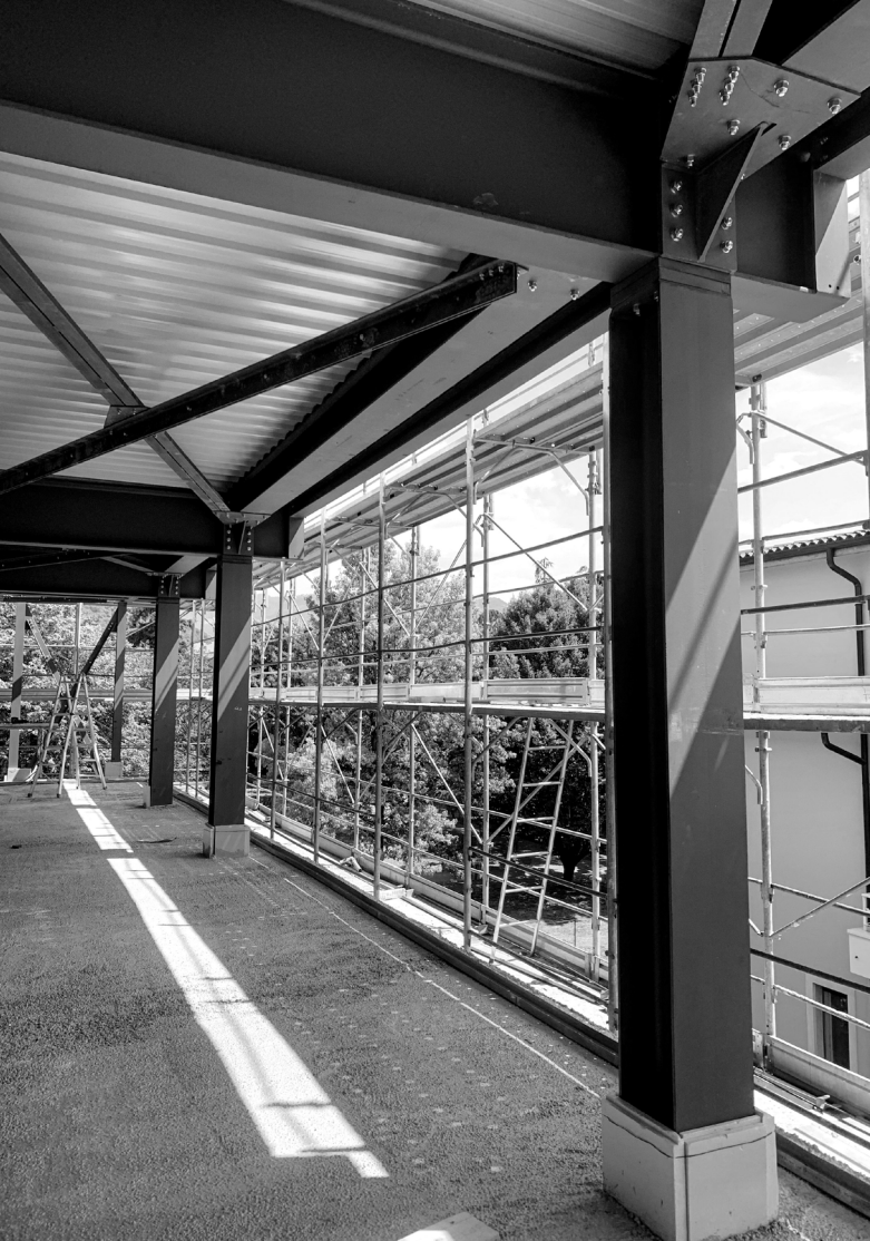
| Rinforzo strutturale per ampliamento passaggio parcheggio sotterraneo
